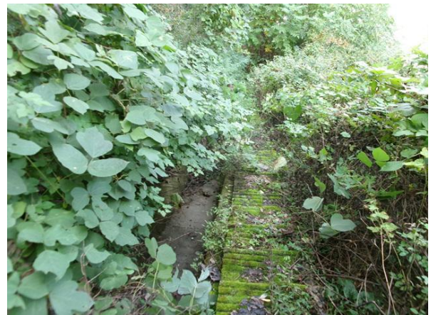
산마루측구, 점검계단 전경
