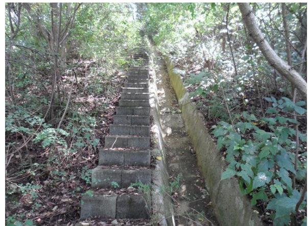
산마루측구, 점검계단 전경
