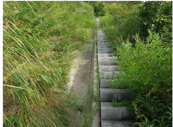
산마루측구, 점검계단 전경
