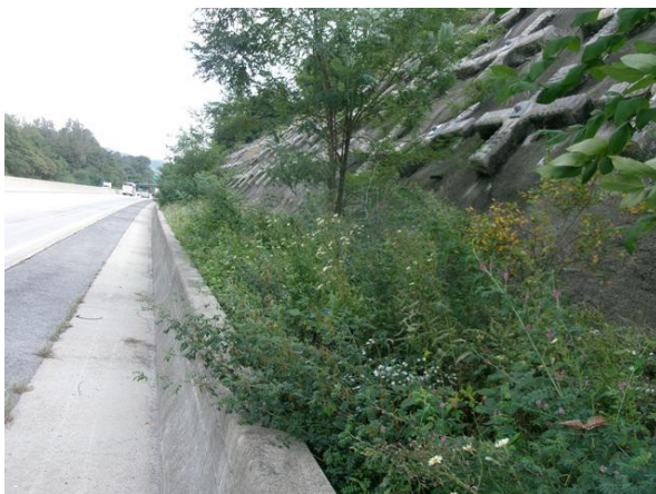
하부, 도로부 전경
