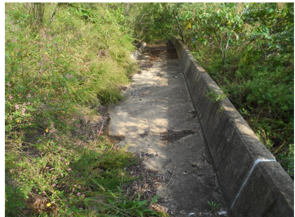
1소단 배수로 전경
