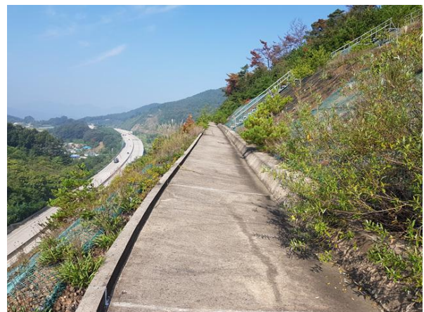
2소단 배수로 전경
