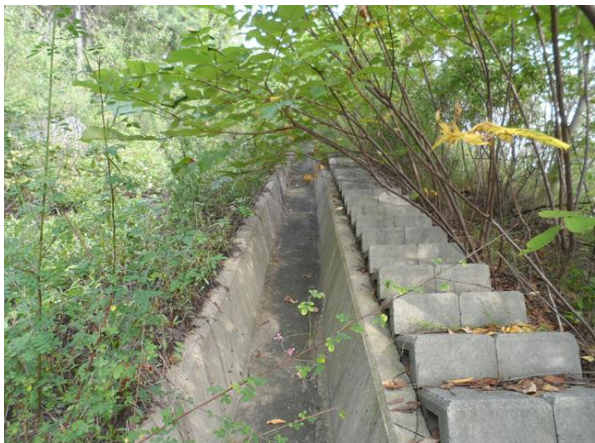
산마루측구, 점검계단 전경
