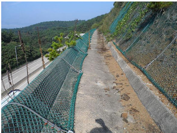
2소단 배수로 전경
