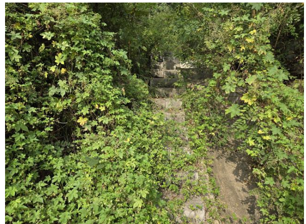
산마루측구, 점검계단 전경
