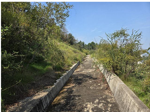
1소단 배수로 전경
