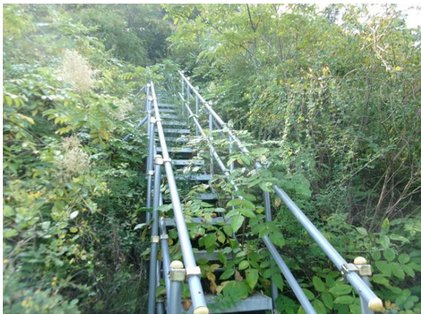
2단 점검계단 전경
