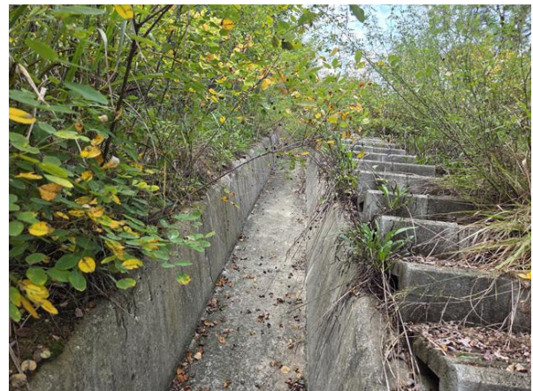
산마루측구, 점점계단 전경
