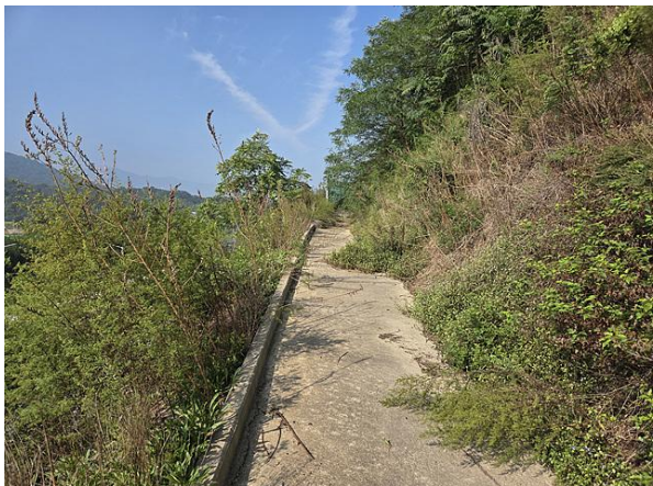
1소단 배수로 전경
