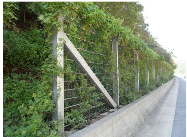
도로, 낙석방지울타리 전경
