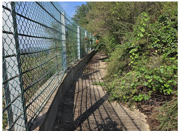
2소단 배수로 전경
