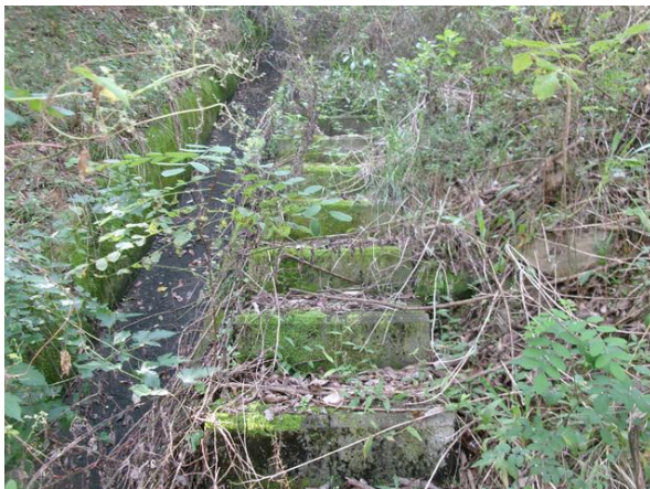
산마루측구, 점검계단 전경
