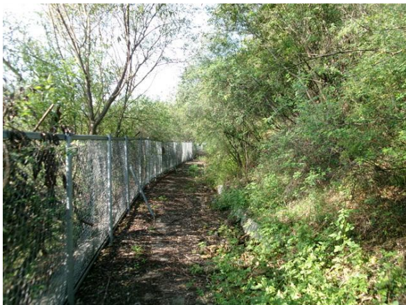
1소단 배수로 전경
