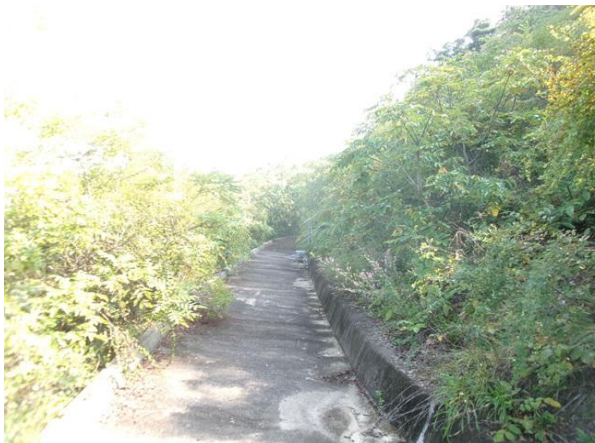
1소단 배수로 전경
