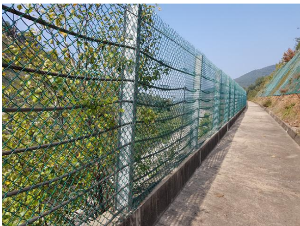
1소단배수로 낙석방지울타리 전경
