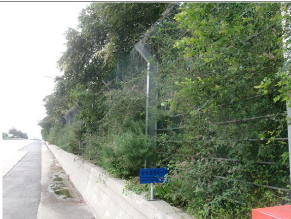
도로, 낙석방지울타리 전경
