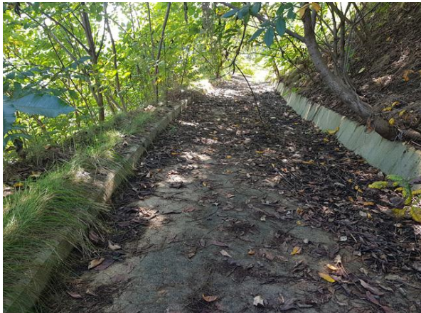
1소단 배수로 전경
