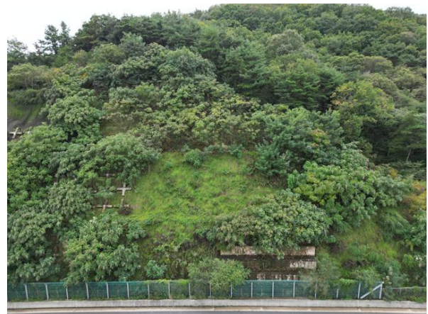
사면내 옹벽 전경
