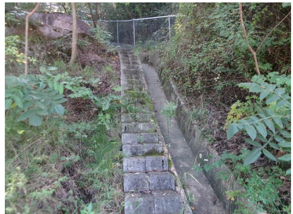
산마루측구, 점검계단 전경
