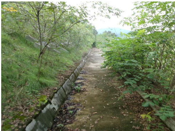
1소단 배수로 전경
