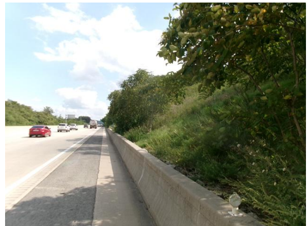
도로, 하부 전경
