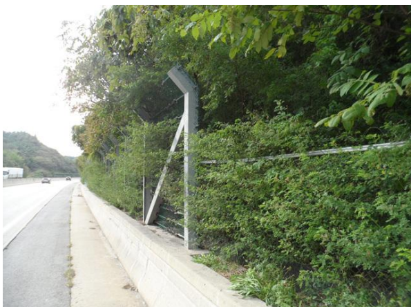
하부, 낙석방지울타리 전경
