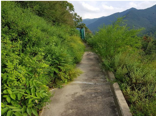
소단배수로, 낙석방지울타리 전경
