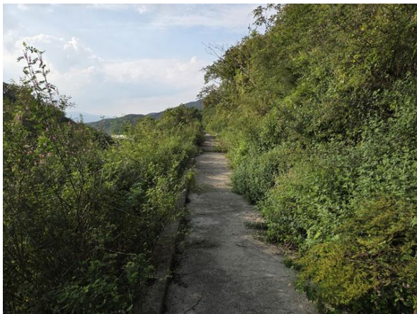
1소단 배수로 전경
