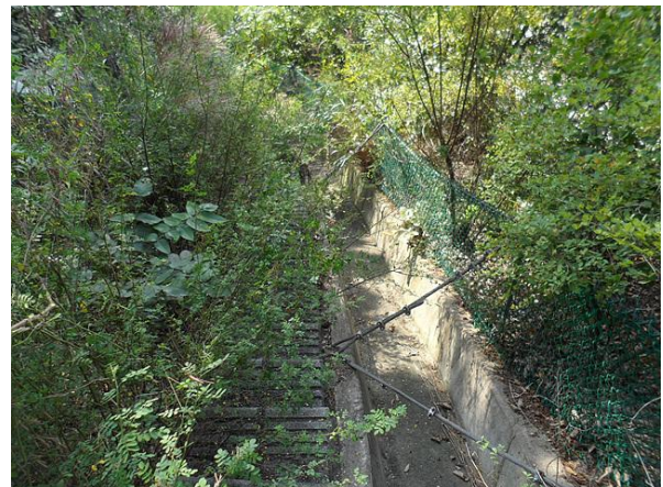
점검계단, 산마루측구 전경
