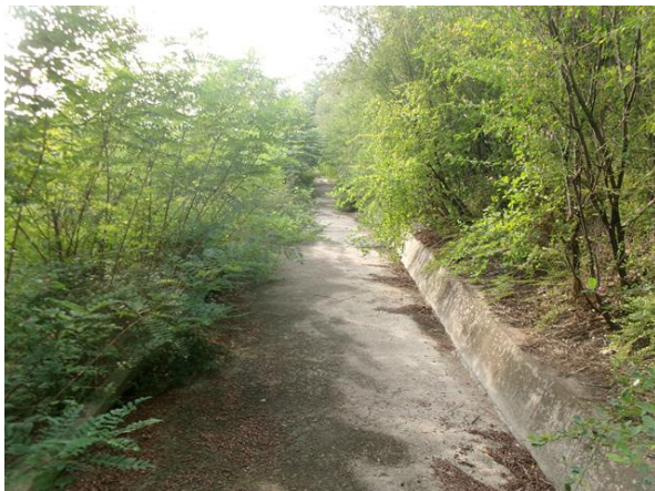
1소단 배수로 전경
