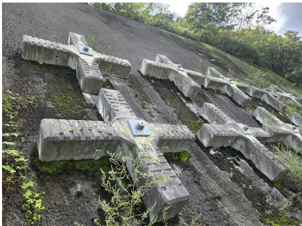
-shot리트, 격자앵커 전경
