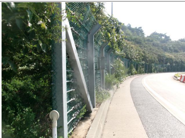
도로, 낙석방지울타리 전경
