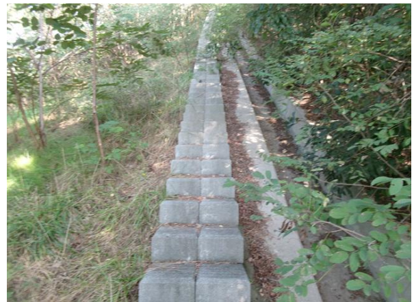
산마루측구, 점점계단 전경
