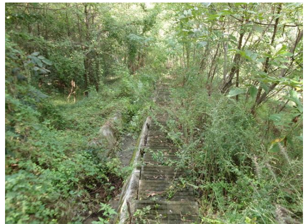
산마루측구, 점검계단 전경
