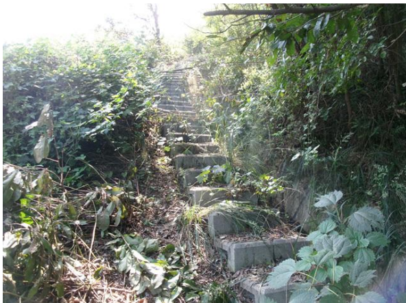
점검계단, 산마루측구 전경
