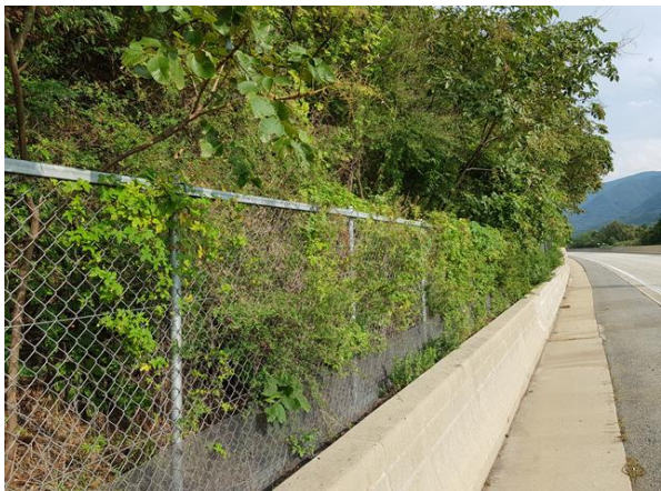
하단 도로부 전경
